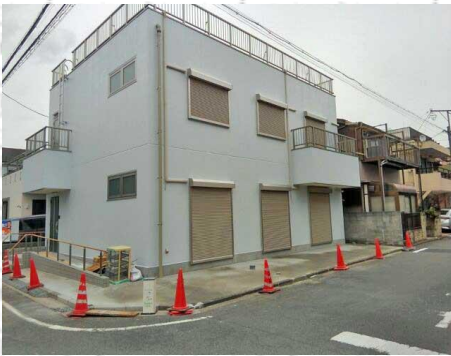
建設中(足場が取れて全形が見えました)
